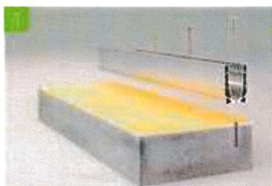
**2** Posizionare le morse all'interno del Profilo ogni 25cm. Non posizionare le morse in corrispondenza delle viti di fissaggio
